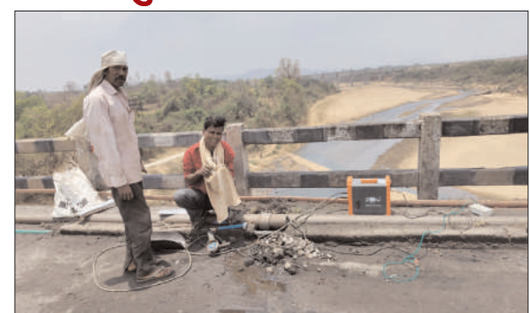
के द्वारा लिंकेज पाइप का मरम्मत का काम शनिवार के सुबह से ही लगाया गया। जहां खराब पाइप को बदल कर नई पाइप लगाई गई है। वहीं इसके
