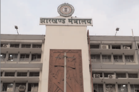
को कहा। पथ निर्माण सचिव ने टोरी रेल ओवर ब्रिज निर्माण कार्य अब
