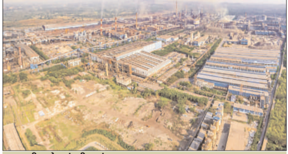
टाटा स्टील मेरामंडली प्लांट
